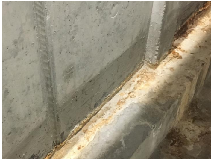
Fot. 7 Ślady po przecieku przy schodach
