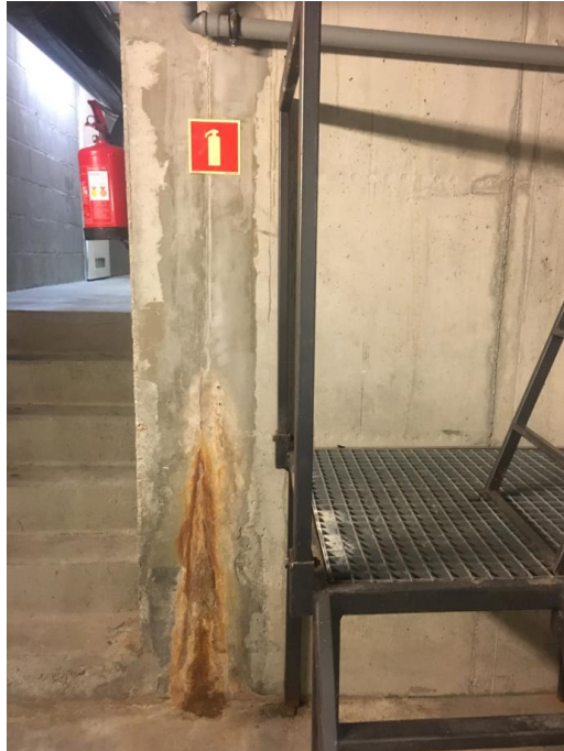
Fot. 7 Ślady po przecieku przy schodach
