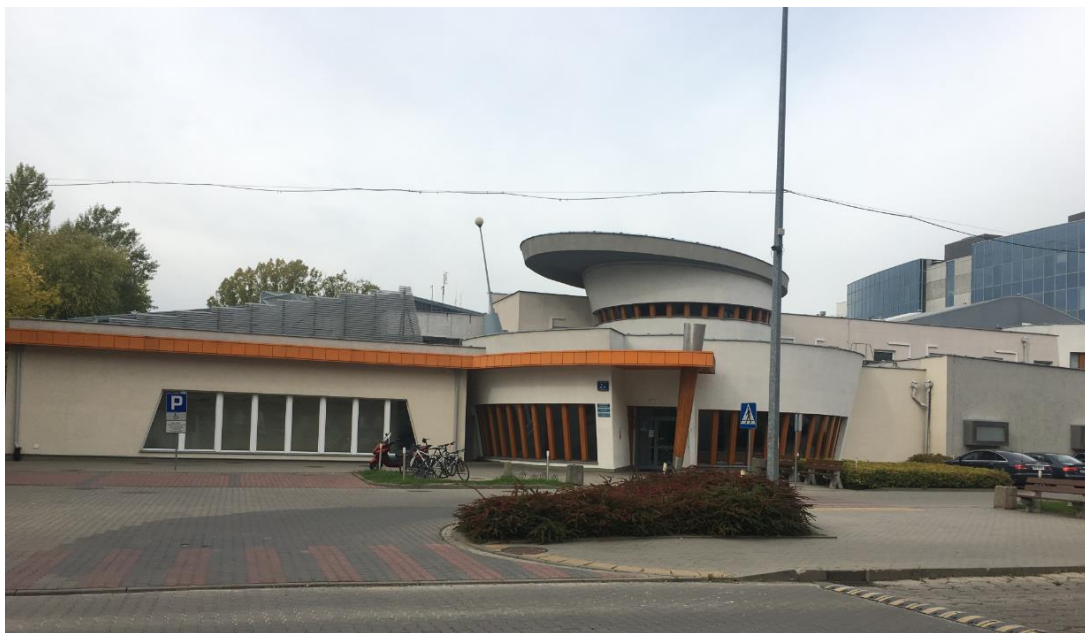
Fot. 1. Widok budynku Centrum Sportu i Rekreacji Uniwersytetu Warszawskiego przy ul. Banacha 2A w Warszawie
