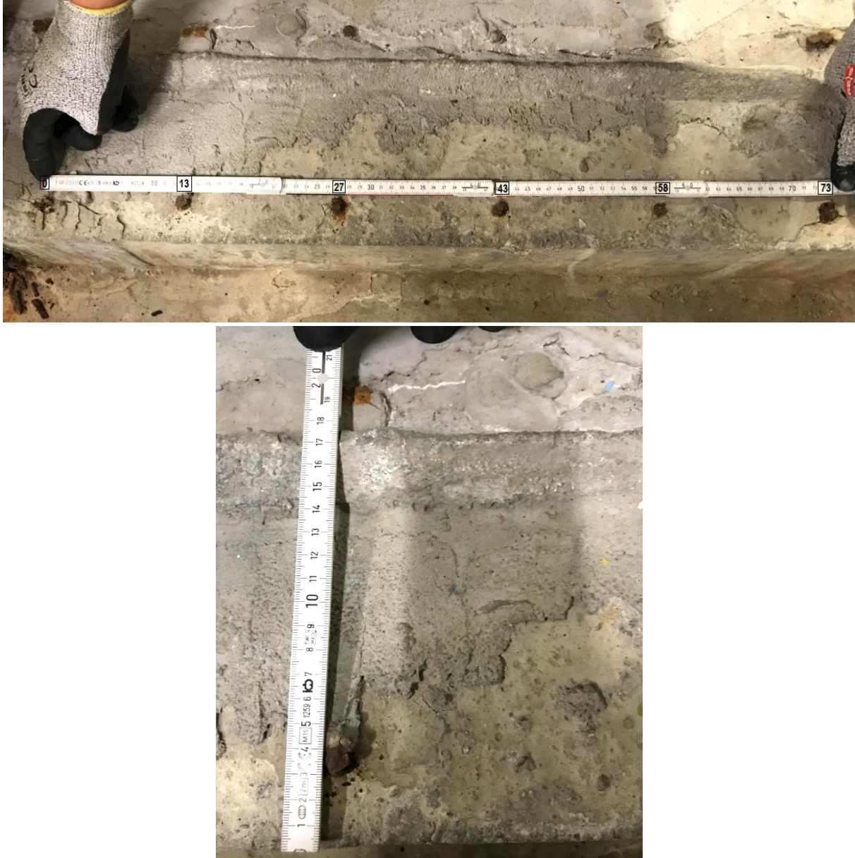
Fot.11 Pomiar rozstawu prętów i otuliny zbrojenia w miejscu otworu drzwiowego.
