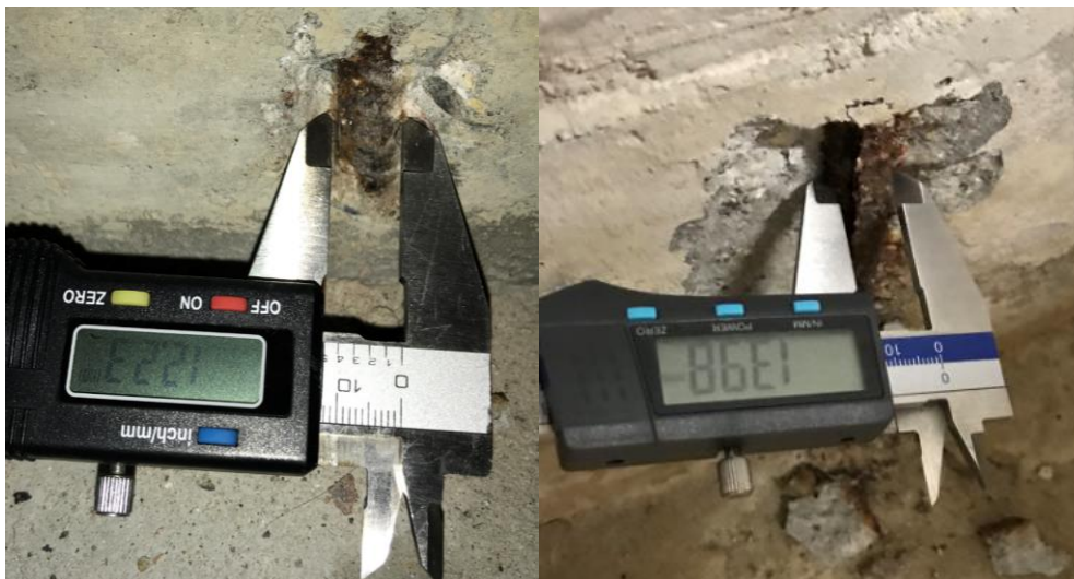
Fot. 17 Pomiary średnic zbrojenia w 2 odkrywkach
