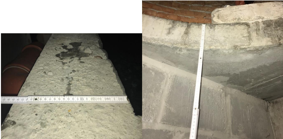
Fot. 9 Kontrolne pomiary geometrii elementów konstrukcyjnych
